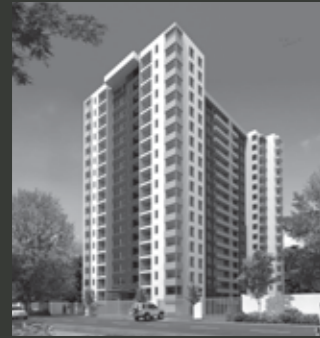
Edificio Armando Mook
